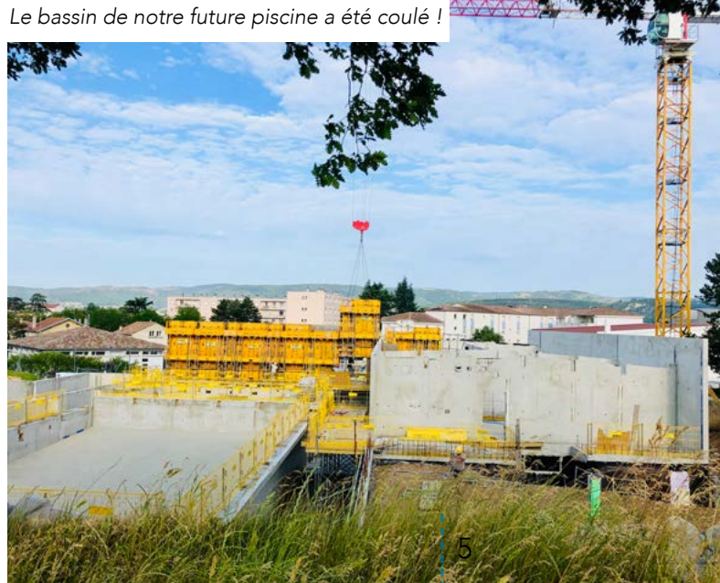
Le bassin de notre future piscine a été coulé !
